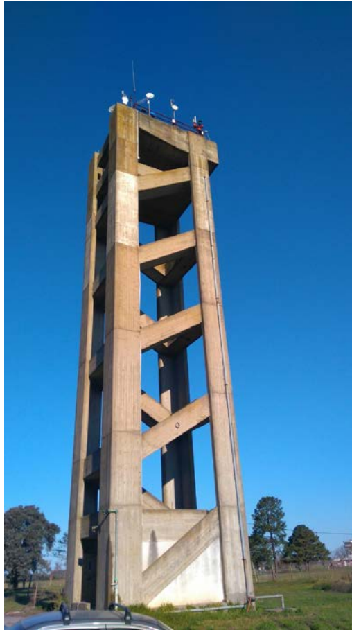
Figura 13: instalación de antena en EMA Aeródromo
