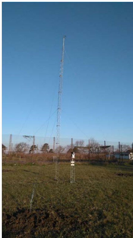
Figura 9: instalación EMA Aeródromo
