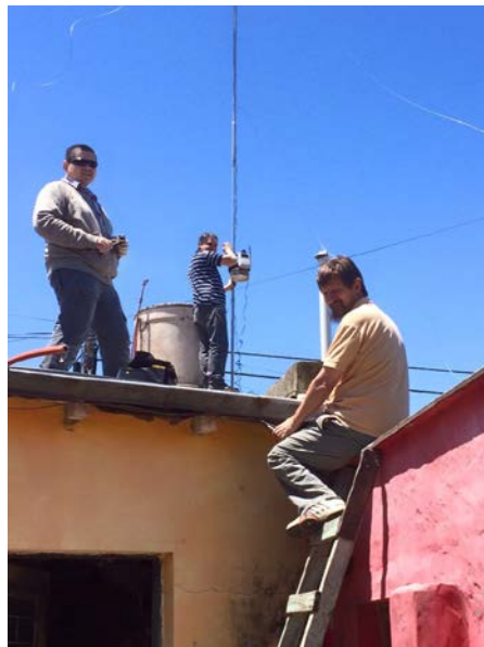
Figura 12: instalación antena emisora EMA LAYHS
